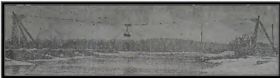
Figura 09: Cabo aéreo - transporte/descarga de carvão. "Companhia Carbonífera Rio Grandense" - Década de 1930 189
