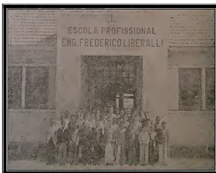
Figura 74: Escola Frederico Liberalli – Fachada – 1944 551
