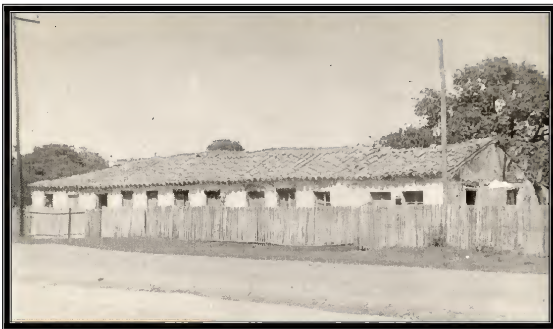
Figura 48: República – Construção em pau a pique. Década de 1920 429
