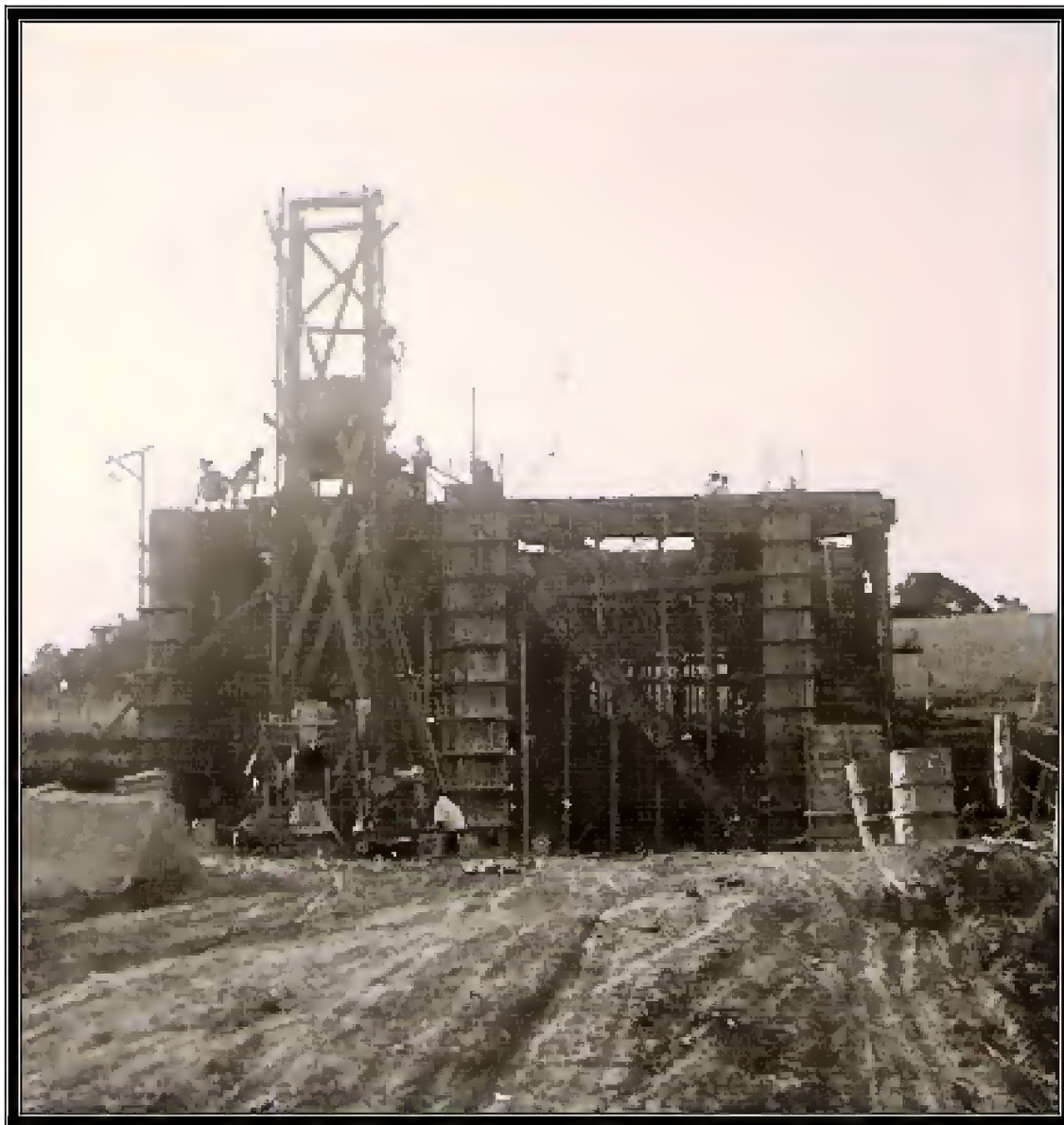
Figura 06: Construção dos silos (São Jerônimo) – fase 1 Final da década de 1920 184
