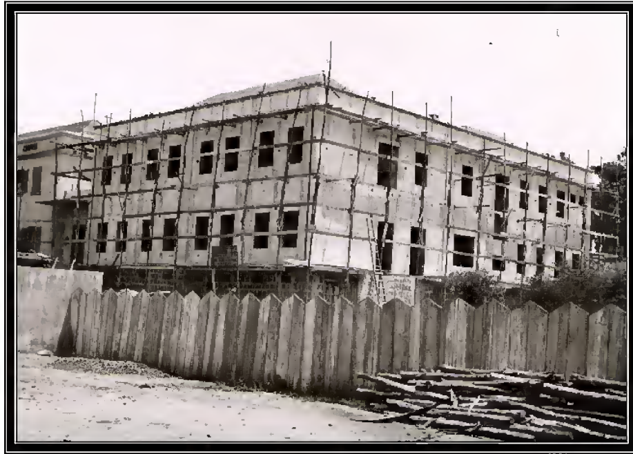
Figura 55: Construção do Hospital Sarmiento Leite - 1941 466
