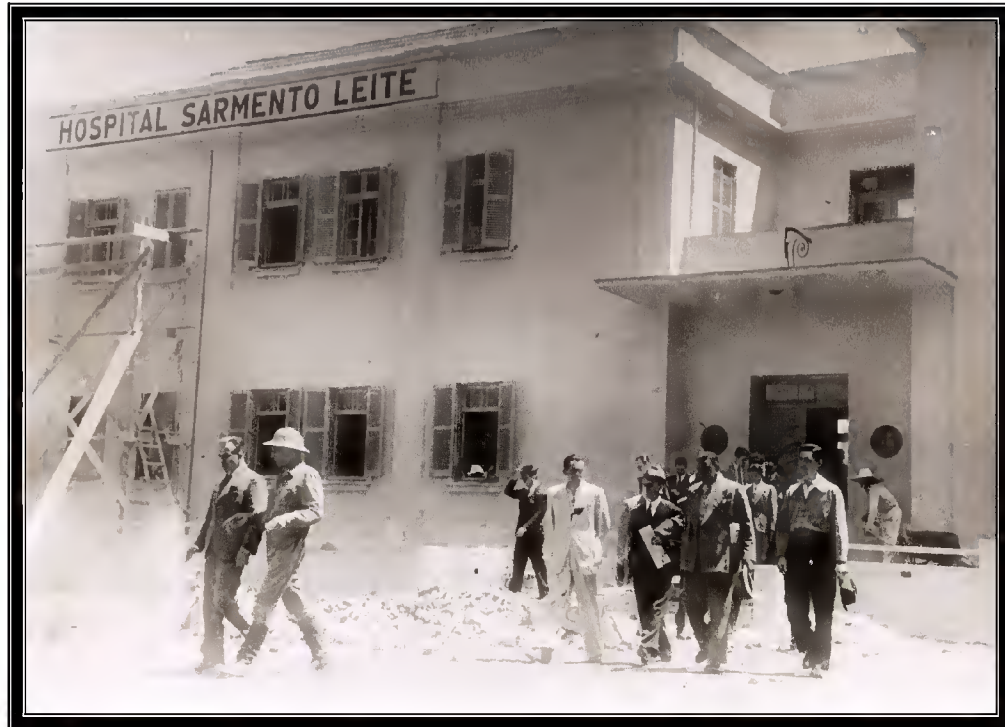
Figura 56: Construção do Hospital Sarmiento Leite - 1942 467
