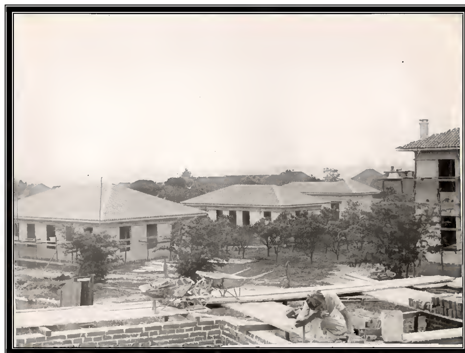
Figura 54: Construção do Hospital Sarmiento Leite - 1941 465
