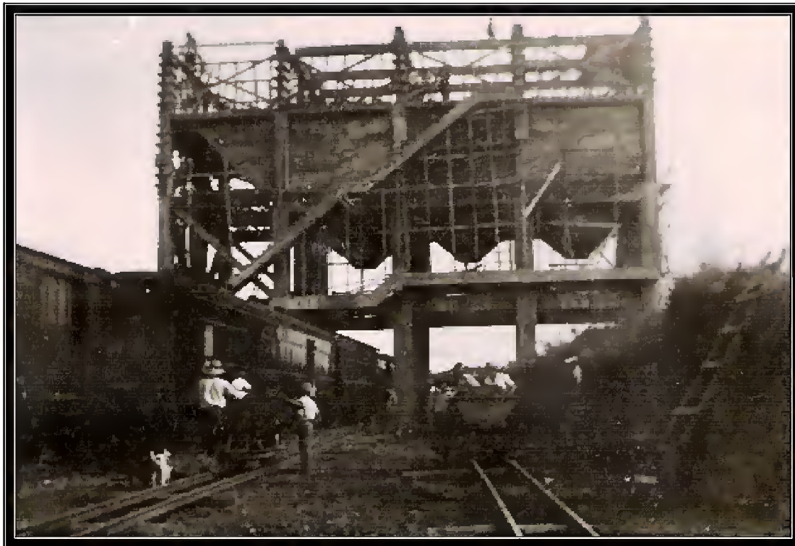
Figura 07: Construção dos silos (São Jerônimo) – fase 2 Final da década de 1920 185
