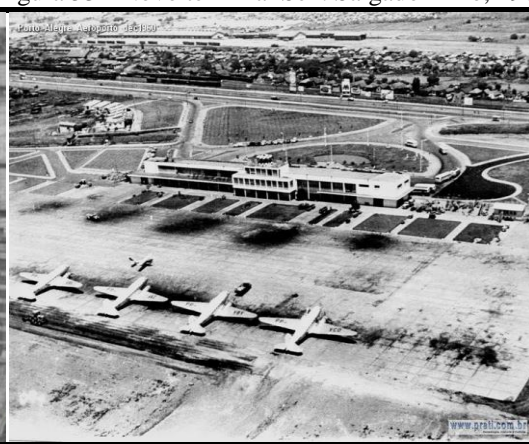
Figura 53 - Novo terminal Sen. Salgado Filho, 1960.
