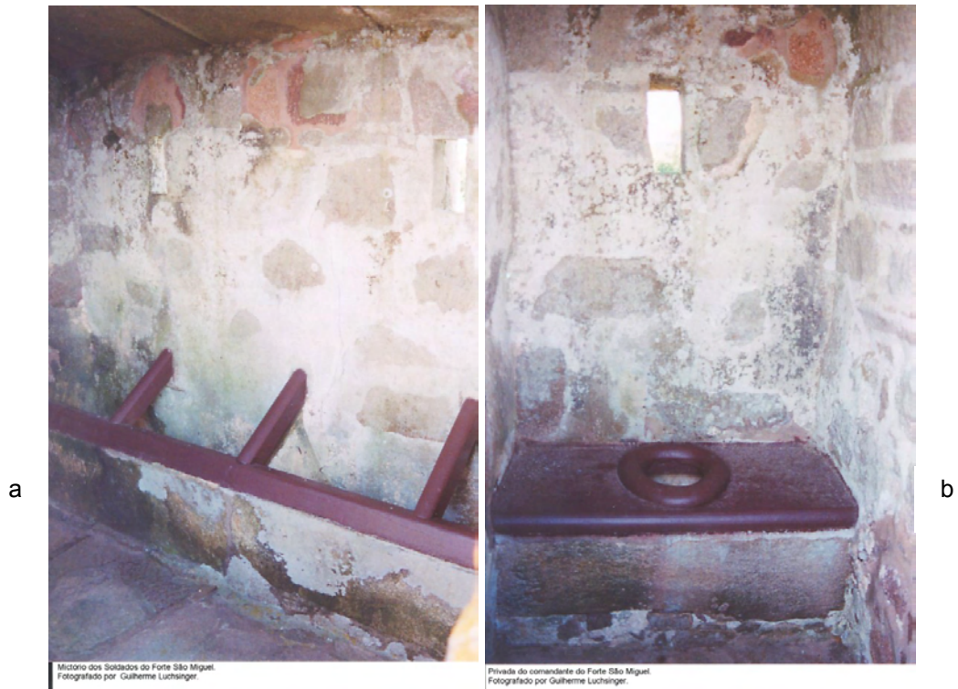
Figura 30a-b: Latrinas: Sítio de São Miguel (2004)
