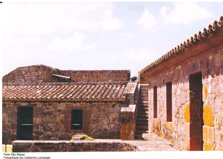
Figura 72: Forte de São Miguel: Escadaria
