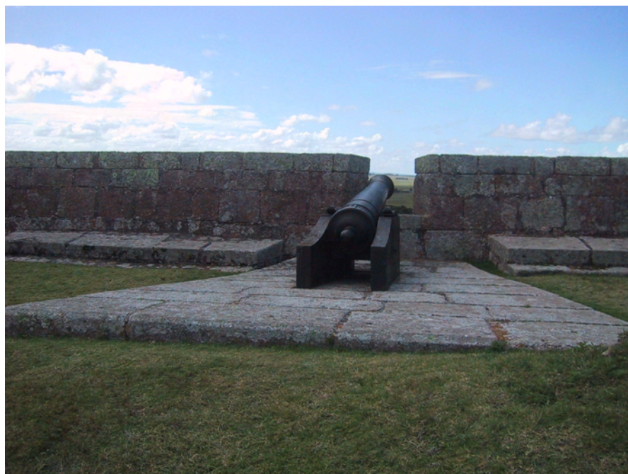
Figura 23: Banqueta. Piso de manobra. Troneira. Sítio Santa Teresa (2003)
