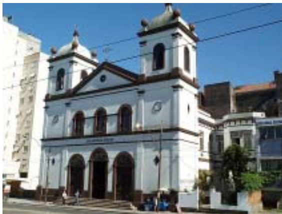
Fig.47 - Igreja Nossa Senhora da Conceição na Av. Independência em frente a praça Dom Sebastião. Fonte:www.terracams.com.br
