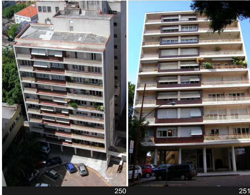
Fig.250- Edifício Linck. Fonte: Fotos Acadêmico João Gallo.
