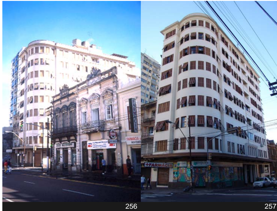
Fig.256- Edifício São Paulo, vista Av. Independência. Fonte: Acervo Maturino da Luz. Fig.257- Edifício São Paulo. Fonte: Fotos Acadêmico Riggs.
