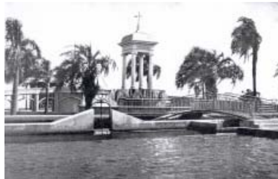
Fig.99 - Hidráulica Municipal de Porto Alegre. Um dos aspectos das instalações na rua Moinhos de Vento. Fonte: COSTA, 1922, p.173.
