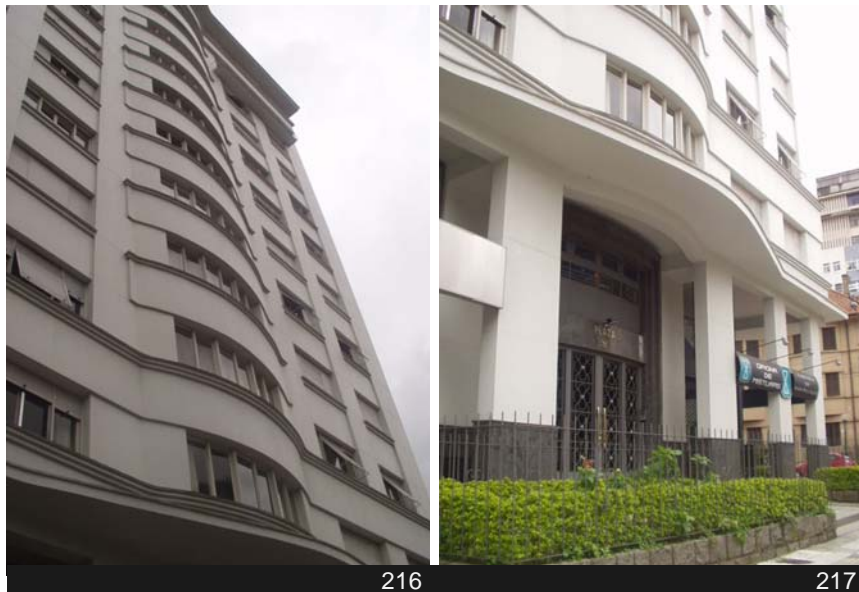
Fig.216 - Edifício Plaza, fachada Praça Júlio de Castilho. Fonte: acadêmica Ecléa Morais. Fig.217 - Edifício Plaza, acesso principal. Fonte: fotos acadêmica Ecléa Morais.
