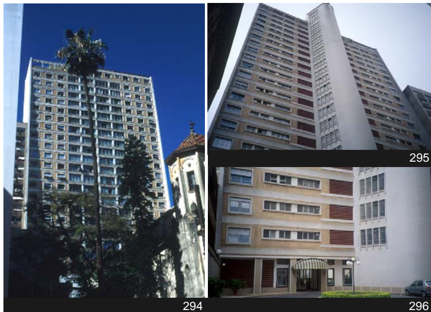
Fig.294 e 295- Edifício Sta tecla. Fonte: Acervo Maturino da Luz.
