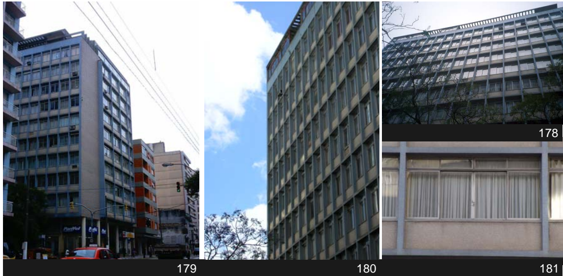
Fig.178 - Edifício Paglioli, detalhe fachada rua Garibaldi. Fonte: Profº Arquiteto Maturino da Luz.
