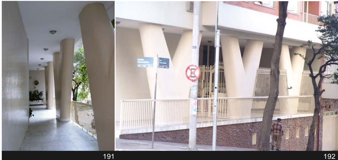
Fig.191 -Edifício José Pilla; detalhe pilotis, vista interna. Fonte: Foto Acadêmico Riggs.
