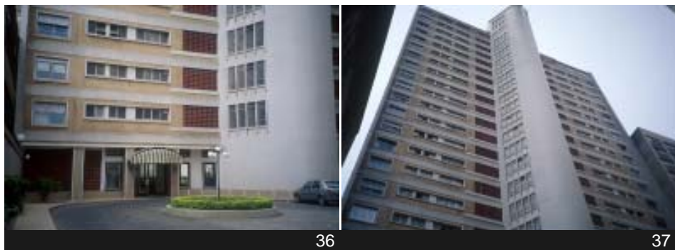
Fig.36 - Edifício Santa Tecla, entrada pela avenida Independência. Fonte: Acervo da autora Fig.37 - Edifício Santa Tecla, vista da fachada da avenida Independência. Fonte: Acervo da autora
