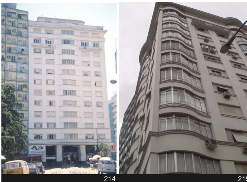
Fig.214 - Edifício Plaza. Fonte: Acervo Maturino da Luz.
