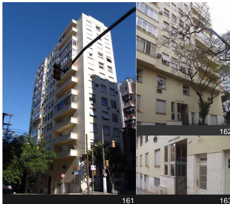
Fig.161 - Edifício Mariante. Fonte: Fotos do acadêmico Riggs.
