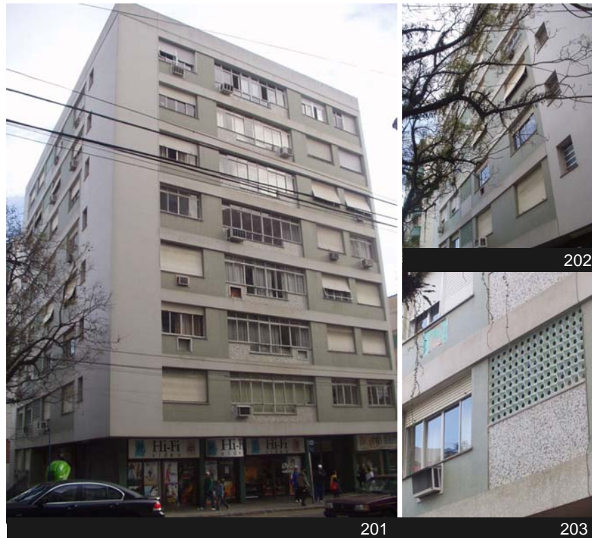
Fig.201 - Edifício Cruzeiro. Fonte: Fotos da acadêmica Ecléa Morais.
