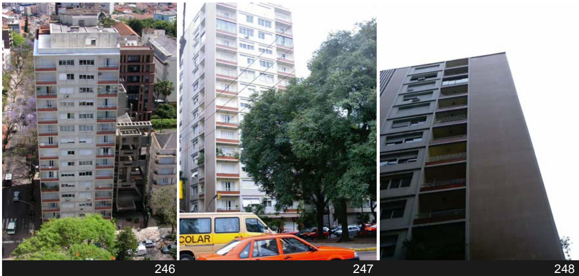
Fig.246- Edifício Embaixador. Fonte: Fotos Acadêmico de arquitetura João Gallo.
