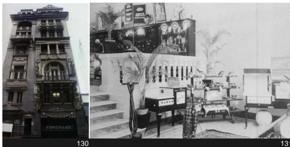
Fig.130 - Fachada do edifício. Fonte:CEEE ERICO VERISSIMO, p. 80.
