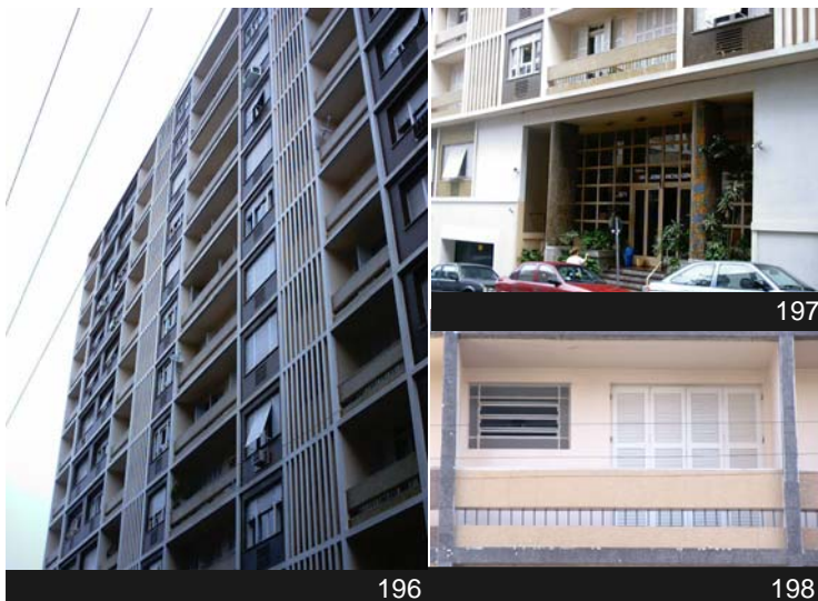
Fig.196 - Edifício José Ricaldone, brises. Fonte: Foto Acadêmico Riggs.
