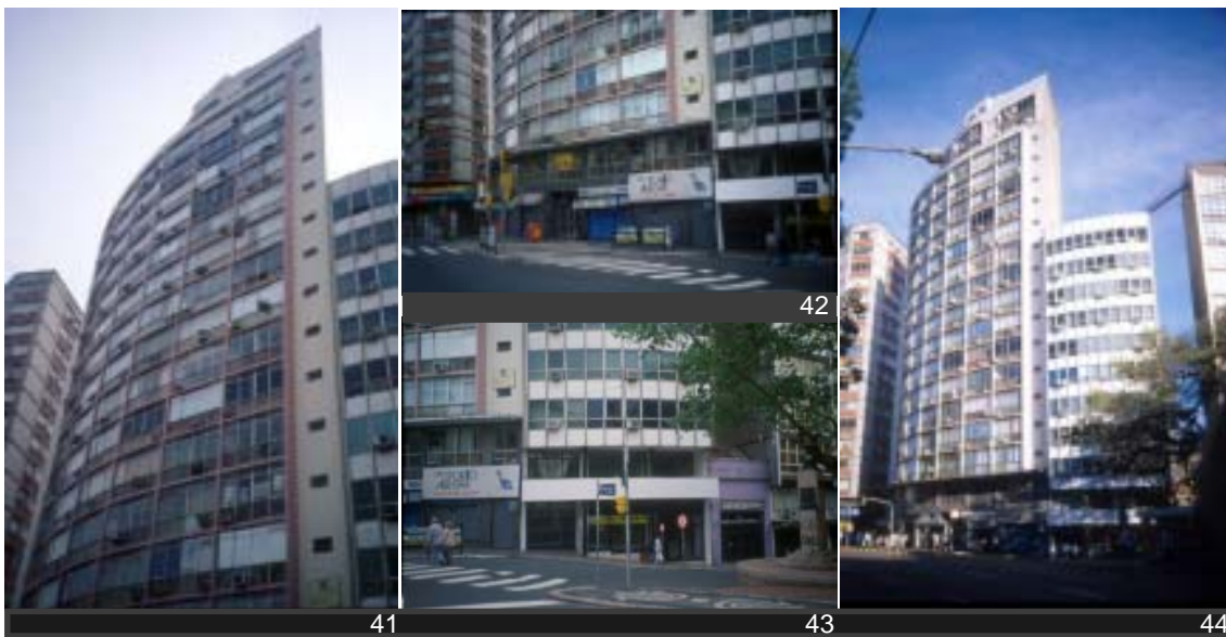
Fig.41 - Edifício Annes Dias, vista da Fachada principal. Fonte: Acervo do Arquiteto Maturino da Luz.
