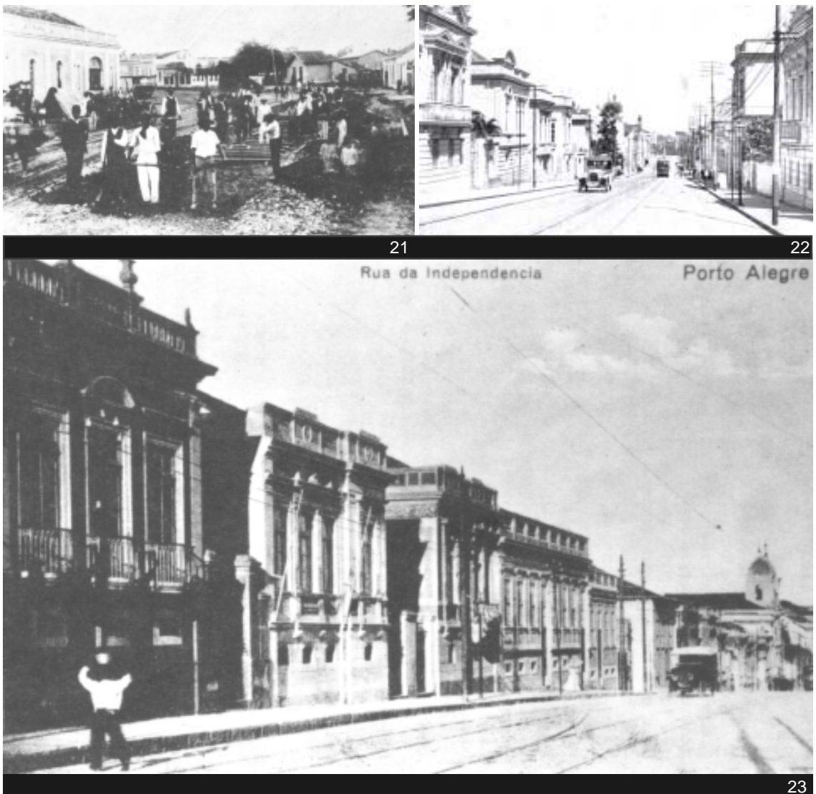
Fig.21 - Colocação de trilhos de bonde na Av. 24 de Outubro, 1907.(fotógrafo: Virgílio Calegari)
