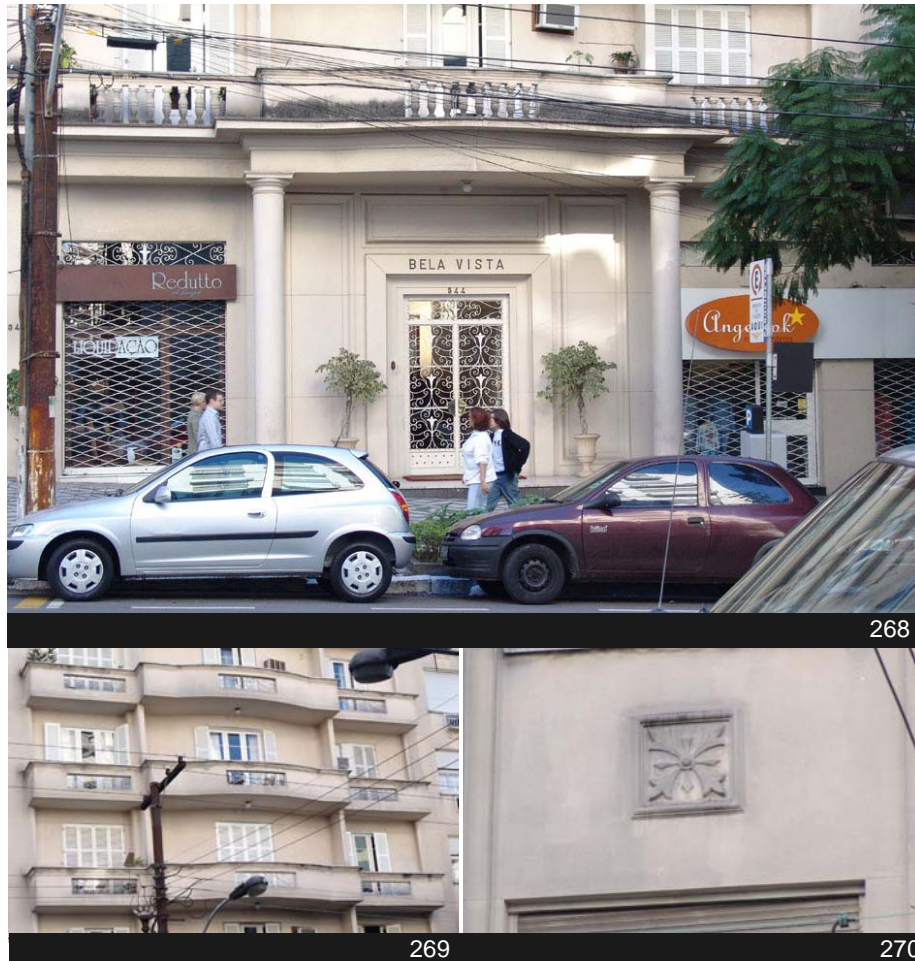
Fig.268 - Edifício Bela Vista, acesso principal. Fonte: Fotos Acadêmico Riggs.
