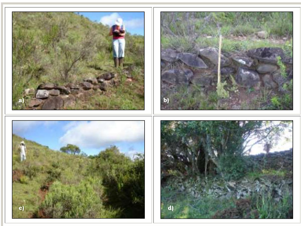
Figura 187 - Muros de arrimo e corte de barranco nos trechos de caminho analisados: a-b) muro de arrimo no leito do caminho no trecho A, subtrecho A4 (pt-30), escala de 50 cm; c) leito da estrada com corte de barranco à esquerda (subtrecho A4, pt-32); d) muro de arrimo construído (subtrecho A5, pt-136)
