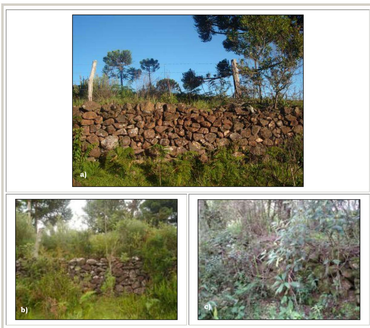
Figura 189 - Trechos com muro de taipa de pedra soterrada, apresentando-se como falso arrimo no subtrecho A5: a) pt-62; b) pt-65; c) pt-92
