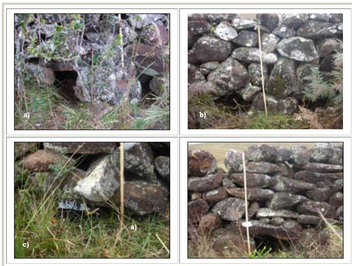
Figura 168 - Drenos dos trechos C e D: a) conjunto de dois drenos disformes (pt-16C); b) dreno disforme (pt-20D); c) dreno disforme (pt-21D); d) dreno quadrangular (pt-22D0, escala 1 m
