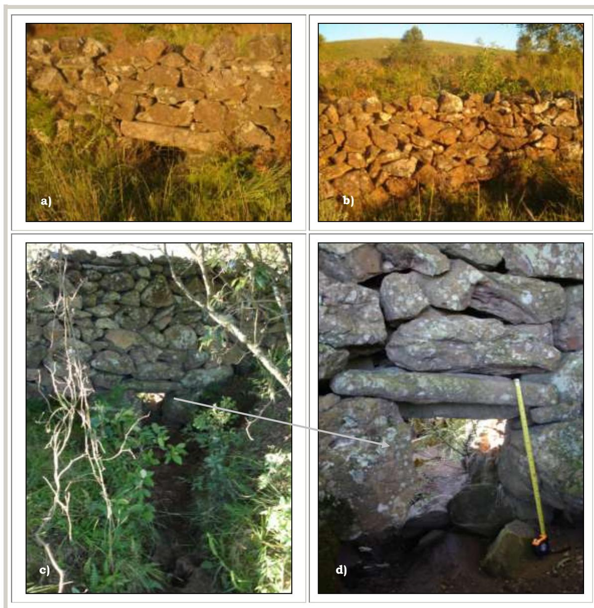
Figura 165 - Drenos do trecho A: a) dreno com forma quadrangular em corredor com desnível (pt-159); b) dreno (pt-161); c-d) dreno quadrangular com vala com seção retangular (pt-136), escala de 50 cm. Fotos: a-b) Adelson André Brüggemann; c-d) A autora. Data: 05/02/2008.
