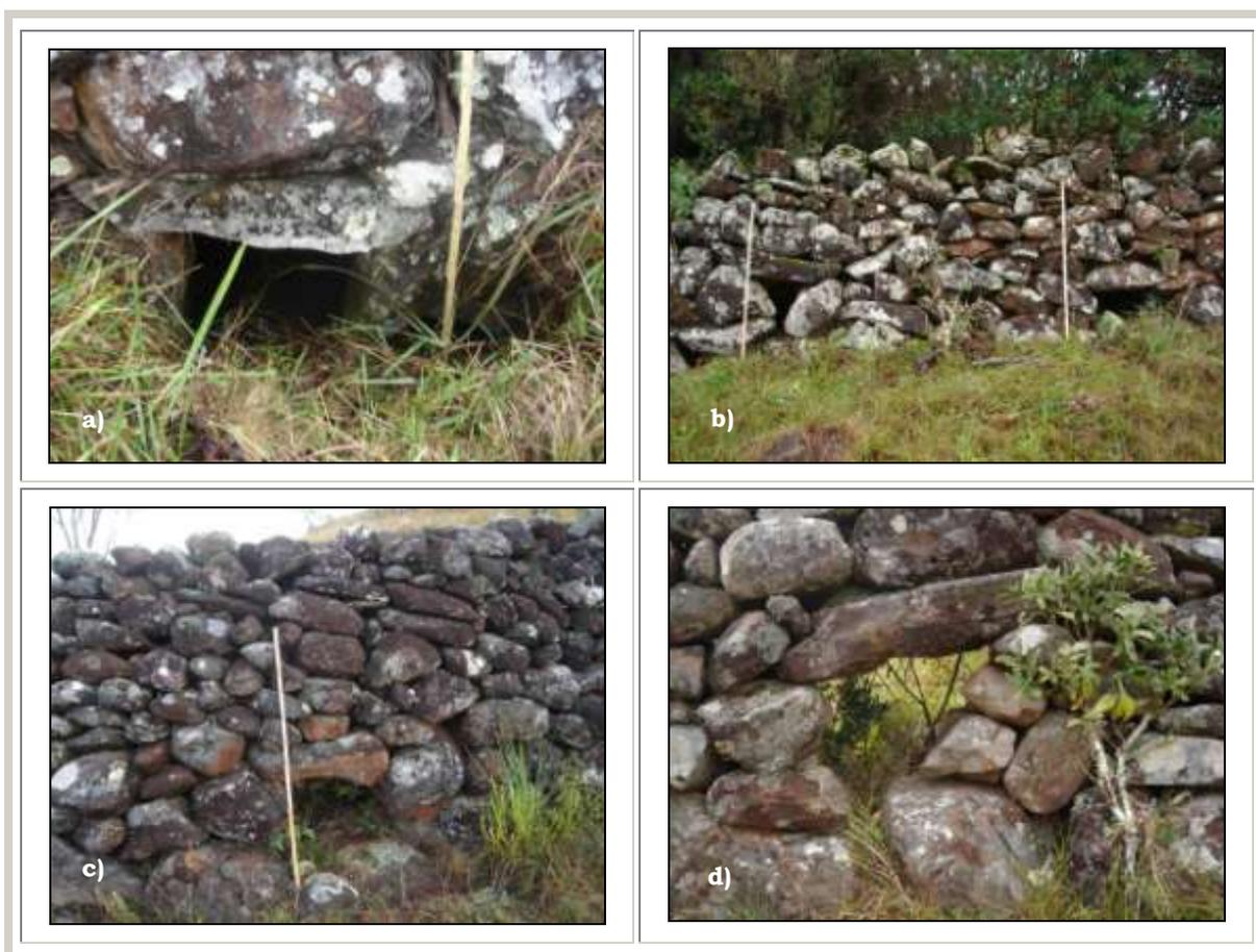
Figura 167 - Drenos do trecho B: a) dreno quadrangular (pt-04); b) conjunto de drenos na taipa (pt-05); c) dreno (pt-07); d) dreno com formato triangular (pt-08), escala com 1 m
