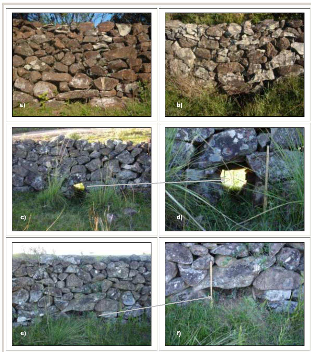
Figura 166 - Drenos do trecho A: a) dreno (pt-55); b) dreno (pt-137); c-d) dreno disforme (pt-143), escala de 50 cm; e-f) dreno construído com uma pedra longitudinal (pt-146), escala de 50 cm; Fotos: a-b) Adelson André Brüggemann. a) Data: 04/02/2008; b) Data: 05/02/2008; c-f) A autora. Data: 05/02/2008.
