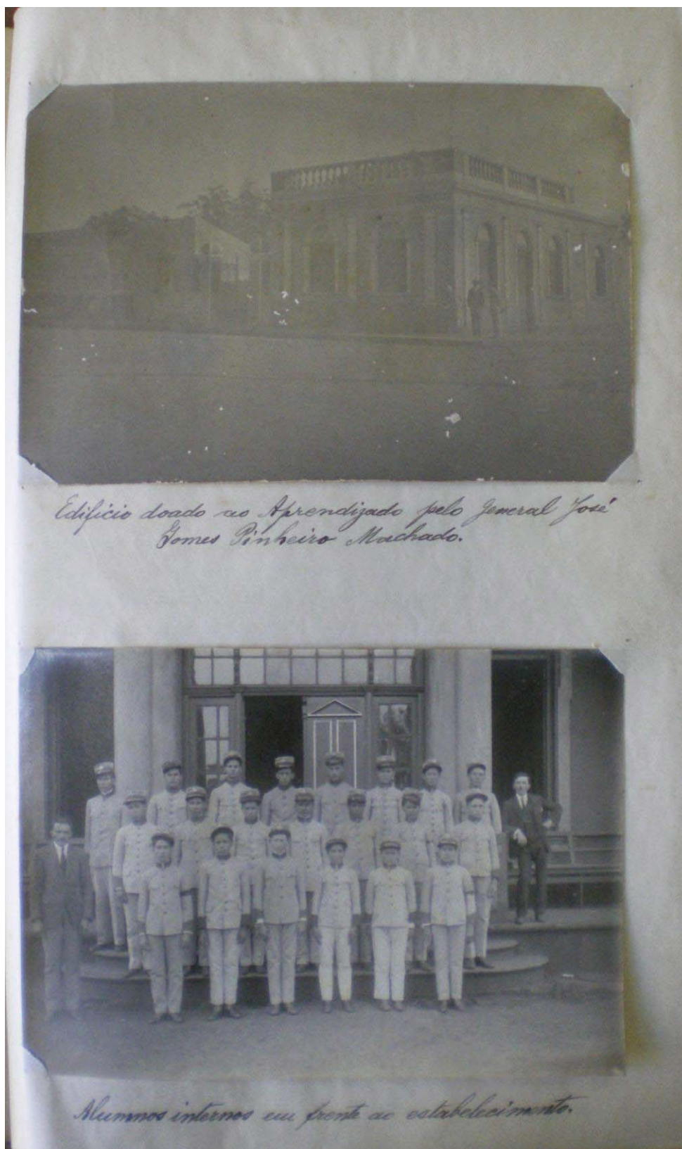
FIGURA 67J - Edifício doado pelo sen. Pinheiro Machado e Alunos internos em frente ao estabelecimento do antigo Aprendizado Agrícola
