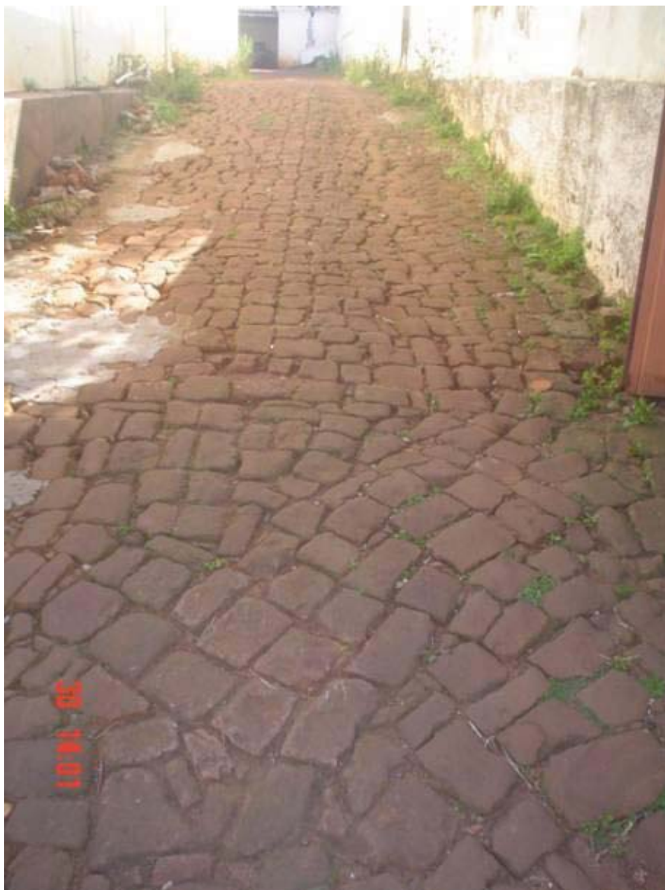
FIGURA 90 - Calçamento em pedra grés do corredor de acesso ao pátio do Sindicato Rural de São Luiz Gonzaga. (aqui ficavam cavalos, carroças, charretes, aranhas, cuja fricção dos rodados provocaram o arredondamento das pedras)
