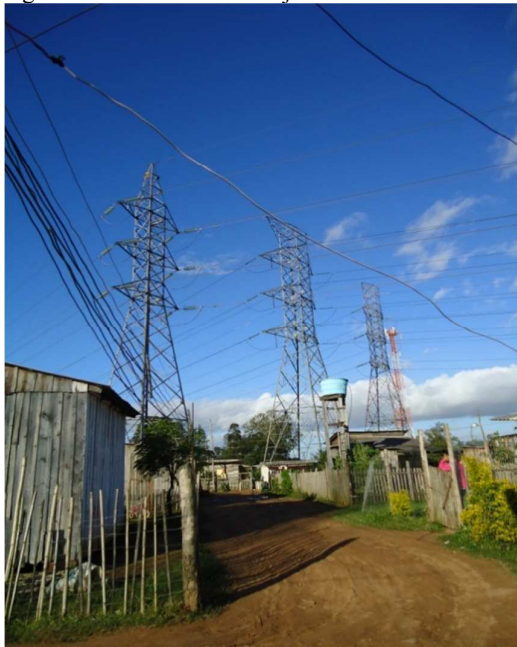
Figura 2: Casas construídas junto à rede de alta tensão
