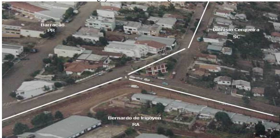
Fig. 6 - Vista aérea das cidades trigêmeas: Barracão/PR, Dionísio Cerqueira/SC e Bernardo de Irigöyen / Misiones - Argentina.
