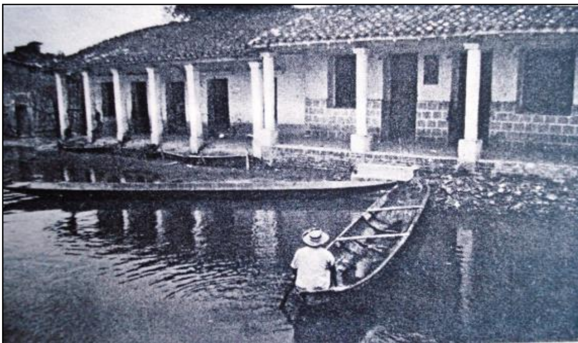
Fig. 24. Rua inundada na borda sul de Trinidad durante a estação chuvosa “seca” de 1962. Fonte: Denevan, 1966.
