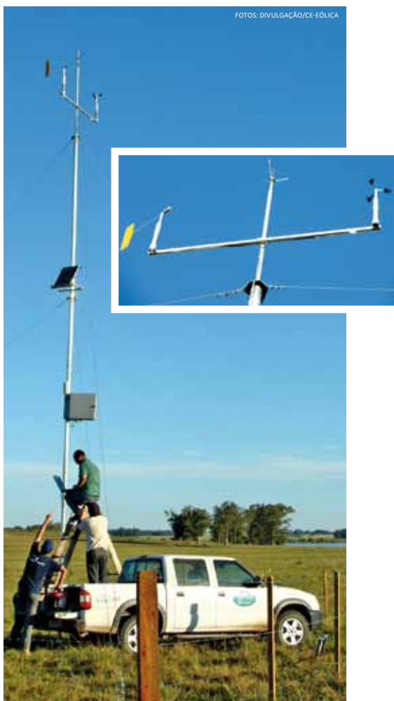
Equipe do CE-Eólica instala torre meteorológica na Estância Guatambu (Dom Pedrito) para monitorar dados dos ventos por um ano
