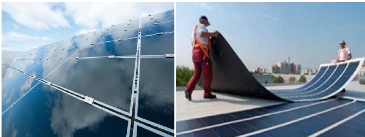
Figura 2.4 – Módulos fotovoltaicos com células de filme fino.
