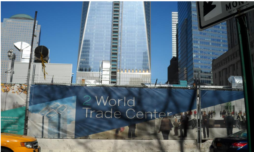
Figura 2: Construção do 2º World Trade Center, Nova Iorque, abril de 2014.
